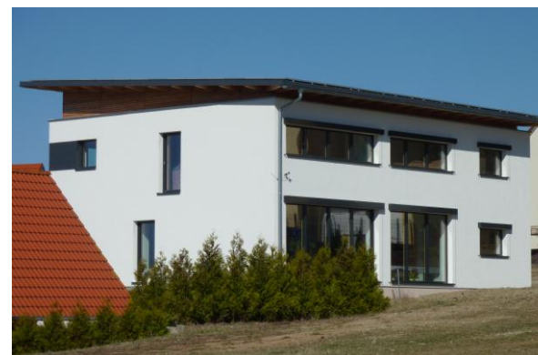
Gartenansicht Wohngebäude mit Büroeinheit
